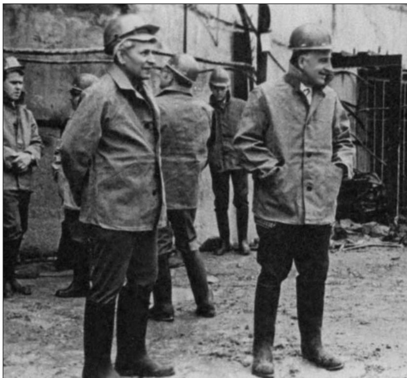
Б.М.Понтекорво и С.С.Герштейн (слева) на строительстве Баксанской нейтринной лаборатории. 1974 г.
